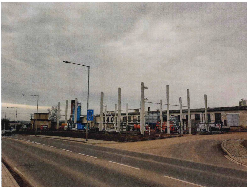
Výstavba nové haly v areálu Dřevotvar
